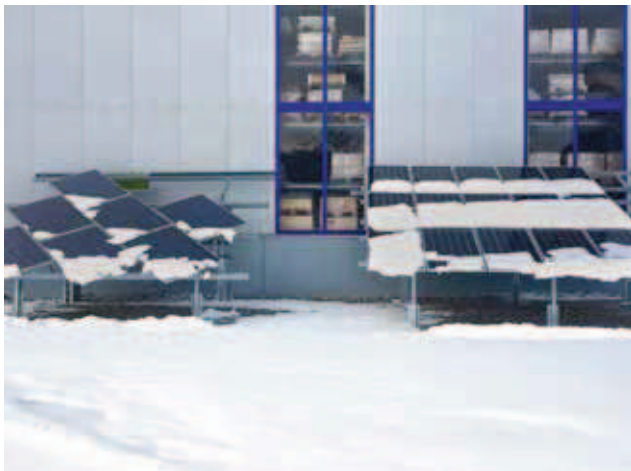
Auch Schnee rutscht bei gedrehter Montage und gleichem Neigungswinkel merklich besser von den Modulen ab.
