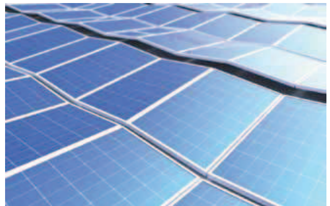
Auch beim sogenannten Diamond Roof zeigt jeweils eine Modulecke nach unten. Knappe Flächen lassen sich damit sehr dicht belegen.
